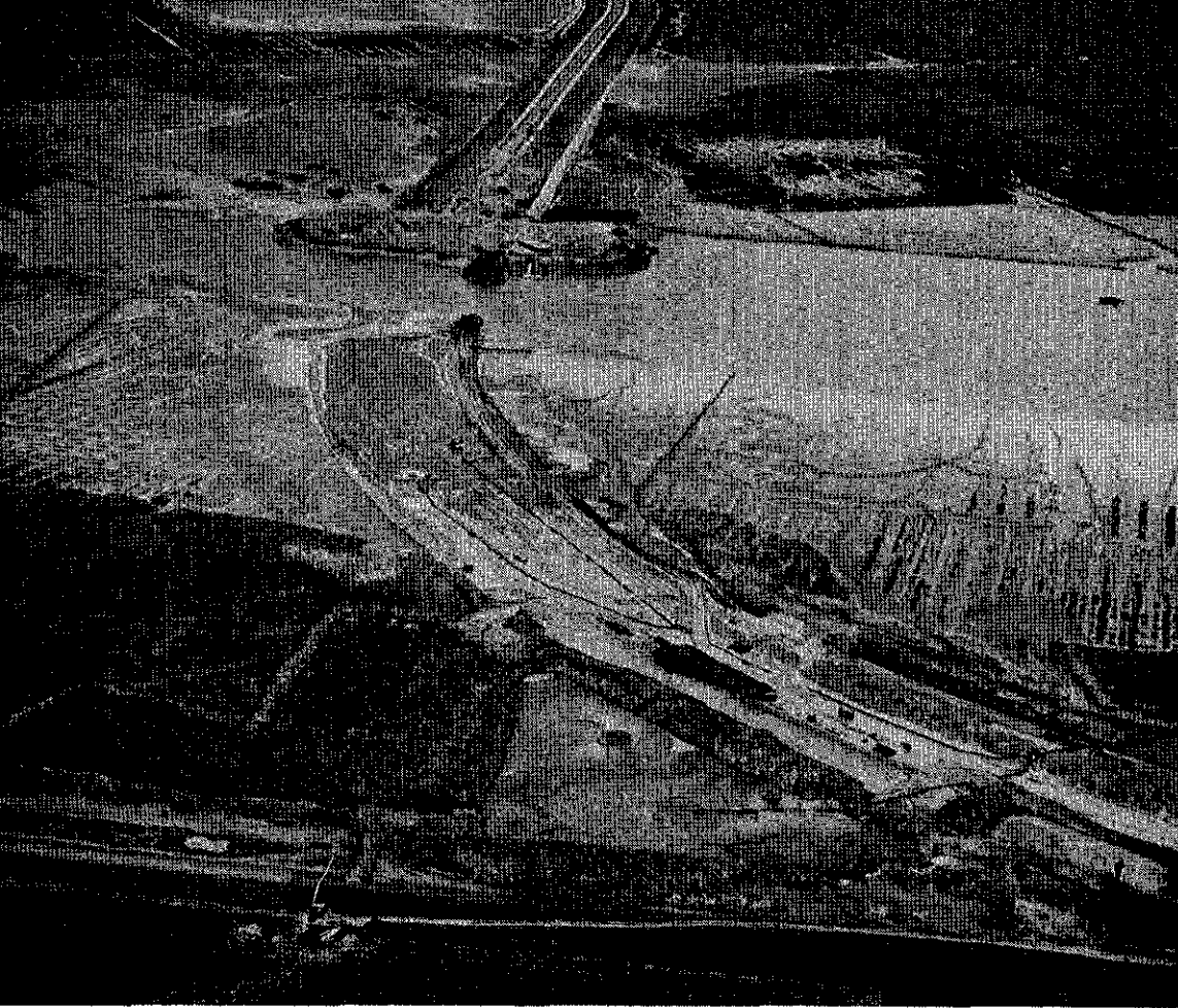
De afsluitdam van het Zuider-Sloe in aanleg. In het tracé van de dam de bouwput voor de uitwateringssluis.
