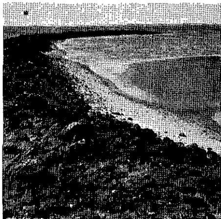
Keileemkade langs de westelijke rand van het werkeiland in de Lauwerszee. Op de achtergrond het eiland Schiermonnikoog.
